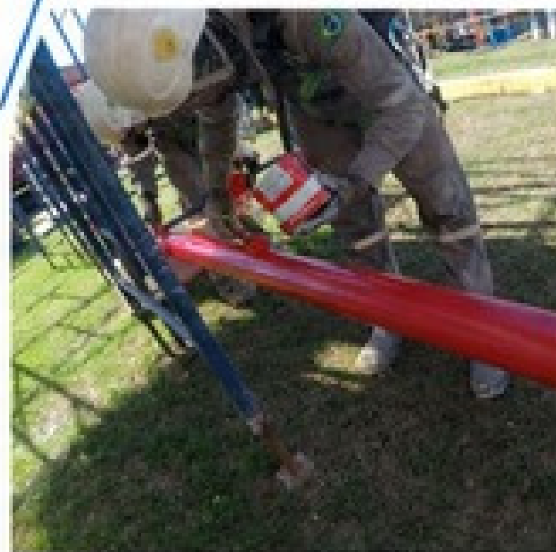
PINTURA DE TUBULAÇÕES INDUSTRIAIS
