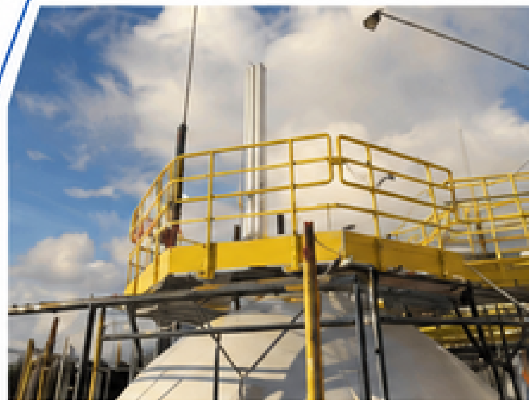
PINTURA DE ESTRUTURAS METÁLICAS
