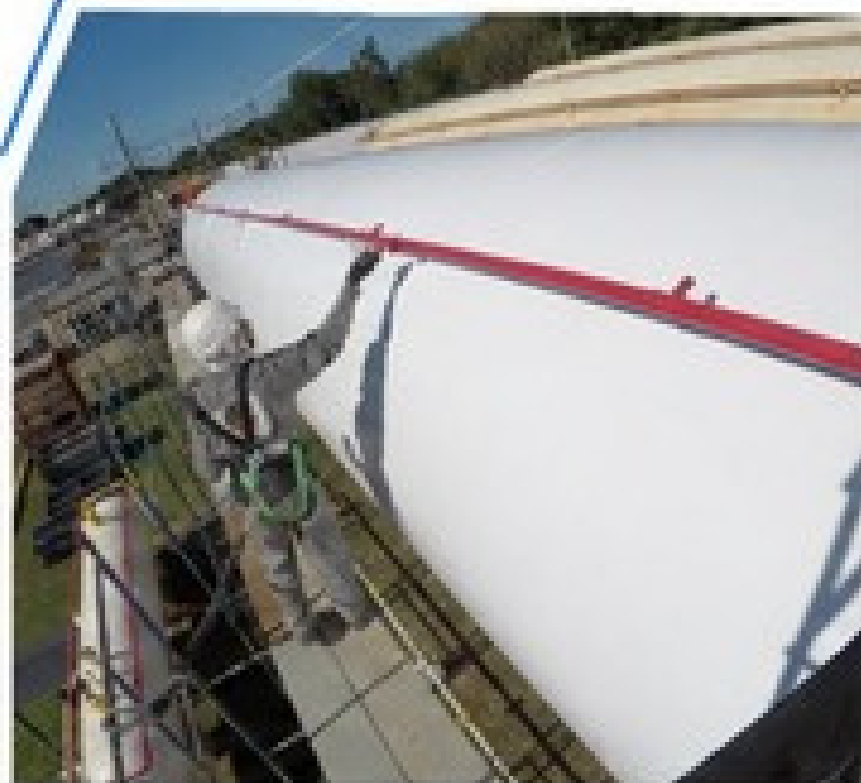
PINTURA EXTERNA DE TANQUES
