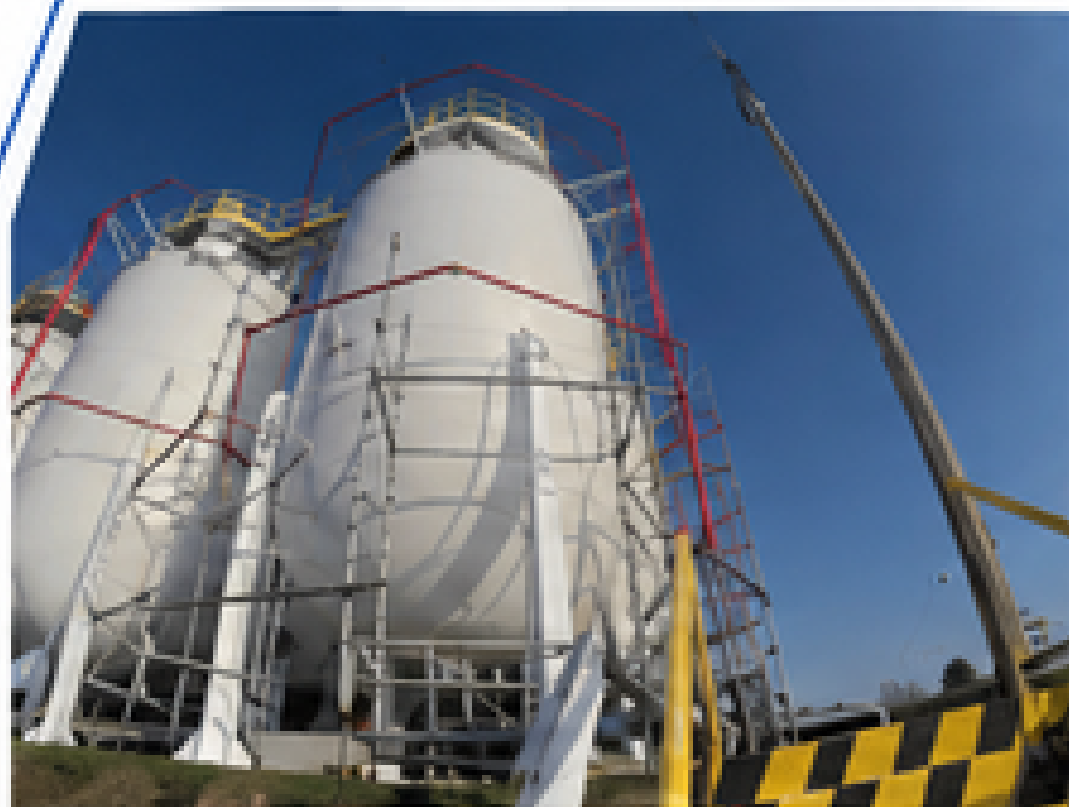
PINTURA E MANUTENÇÃO DE TANQUES
