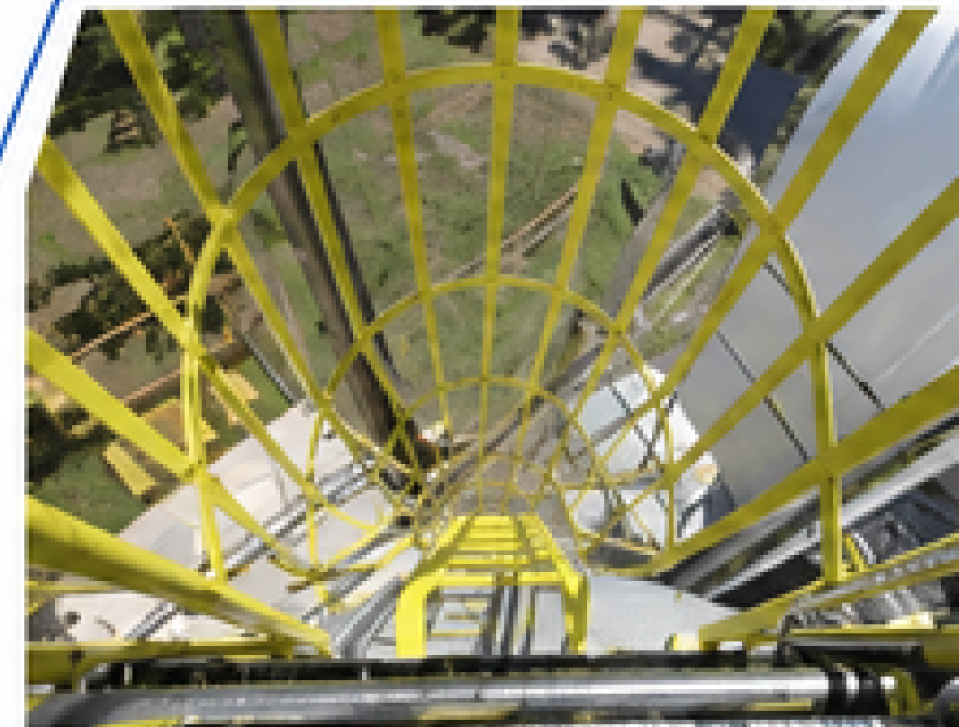
ADEQUAÇÃO E PROTEÇÃO DE ESTRUTURAS
